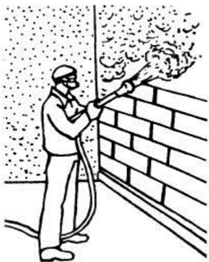
Рисунок 5 - Последовательное нанесение слоев обрызга, грунта
