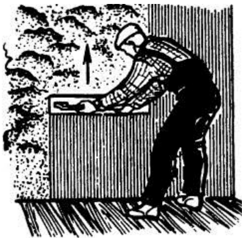
Рисунок 6 - Разравнивание раствора полутерком
