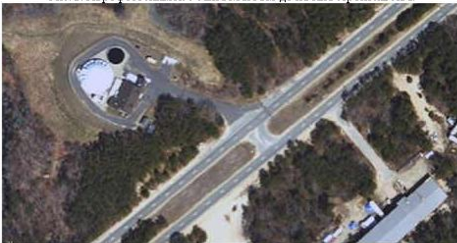
Рис. 4. Аэрофотоснимок с сайта MassGIS после завершения строительства.
