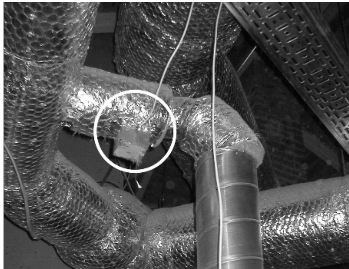
Рисунок 8 – Размещение акустического излучателя вне воздуховода
