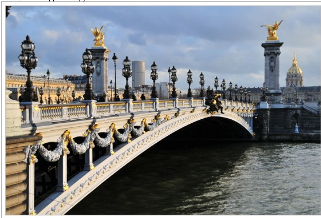
Мост Александра III
