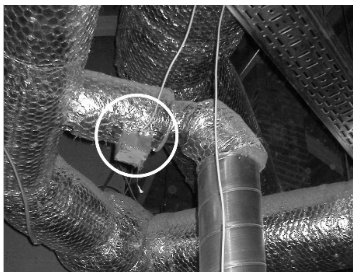
Рисунок 8 – Размещение акустического излучателя вне воздуховода
