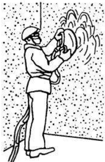
Рисунок 8 – Механизированная затирка поверхности
