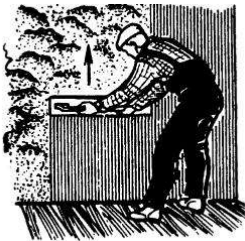
Рисунок 6 - Разравнивание раствора полутерком
