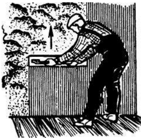
Рисунок 6 - Разравнивание раствора полутерком
