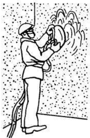
Рисунок 8 – Механизированная затирка поверхности
