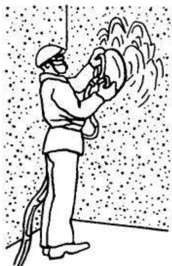
Рисунок 8 – Механизированная затирка поверхности
