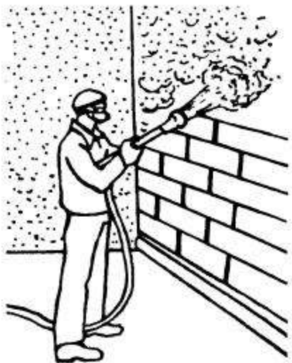
Рисунок 5 - Последовательное нанесение слоев обрызга, грунта
