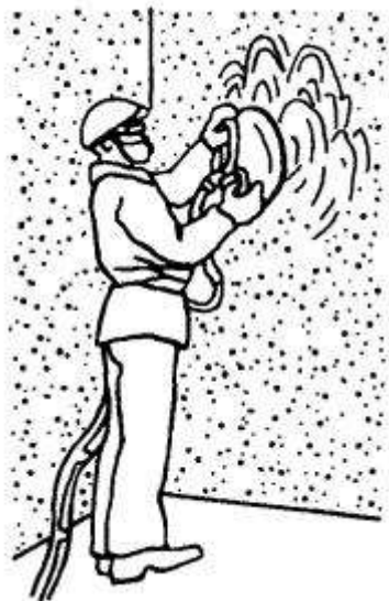
Рисунок 8 – Механизированная затирка поверхности
