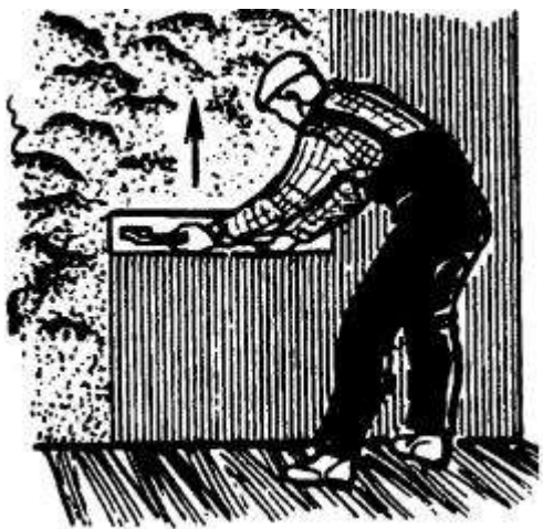
Рисунок 6 - Разравнивание раствора полутерком
