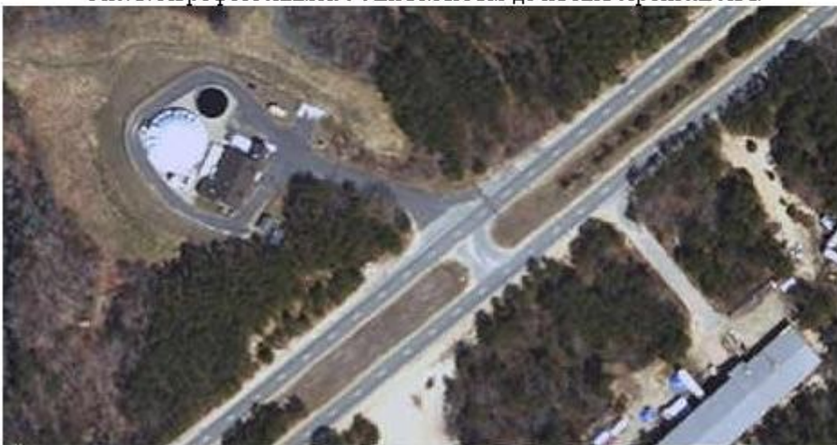
Рис. 4. Аэрофотоснимок с сайта MassGIS после завершения строительства.
