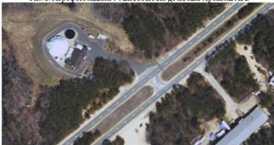
Рис. 4. Аэрофотоснимок с сайта MassGIS после завершения строительства.
