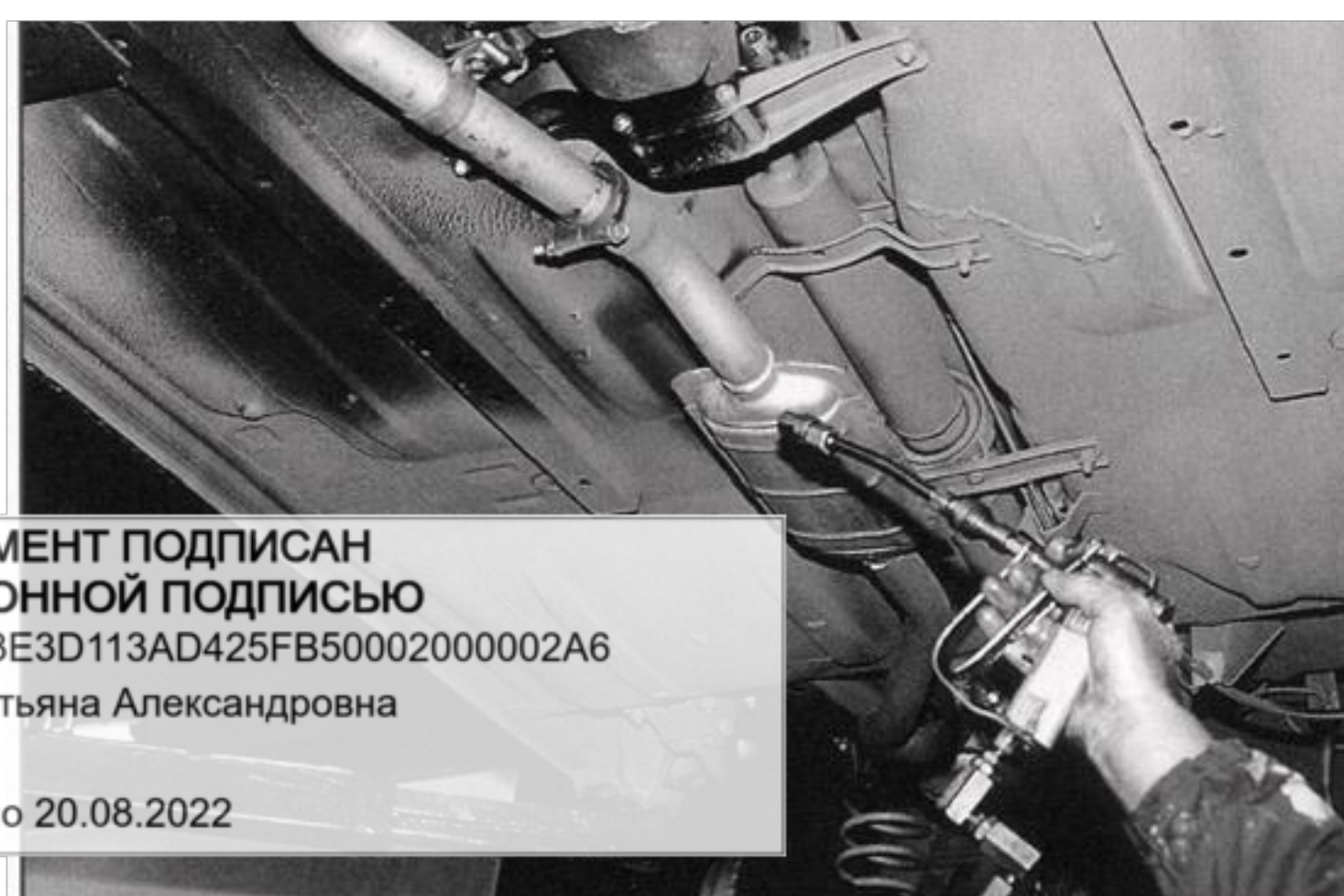
Рис. 20. Фрагмент нанесения защитного покрытия
