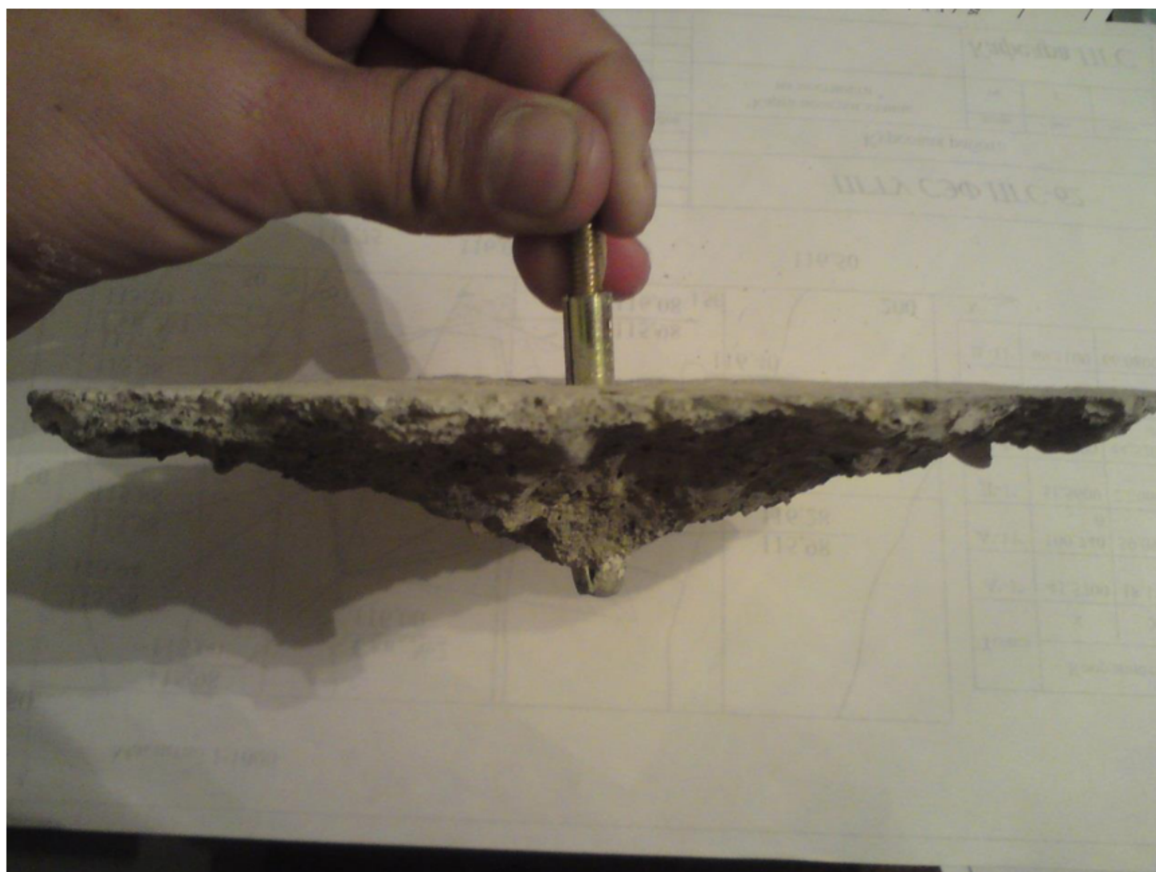
Рис. 4.6.3. Бетон, вырванный из тела конструкции, имеет коническую форму.
