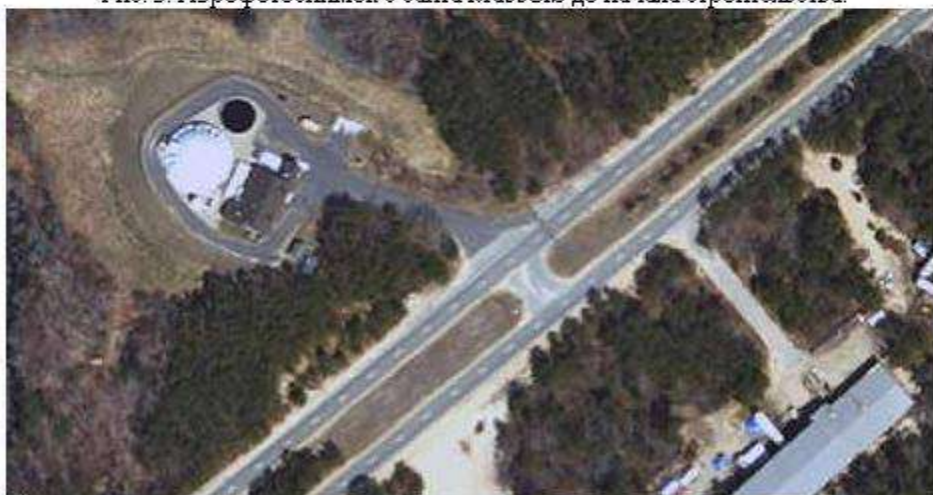
Рис. 4. Аэрофотоснимок с сайта MassGIS после завершения строительства.
