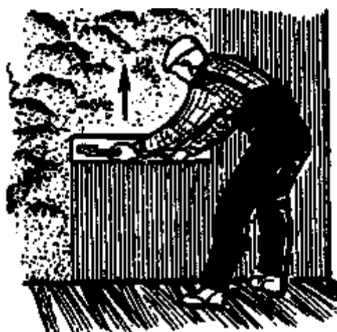
Рисунок 5 - Последовательное нанесение слоев обрызга, грунта
