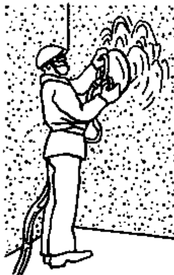
Рисунок 8 – Механизированная затирка поверхности
