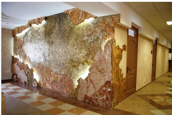
Отделка декоративной штукатуркой
