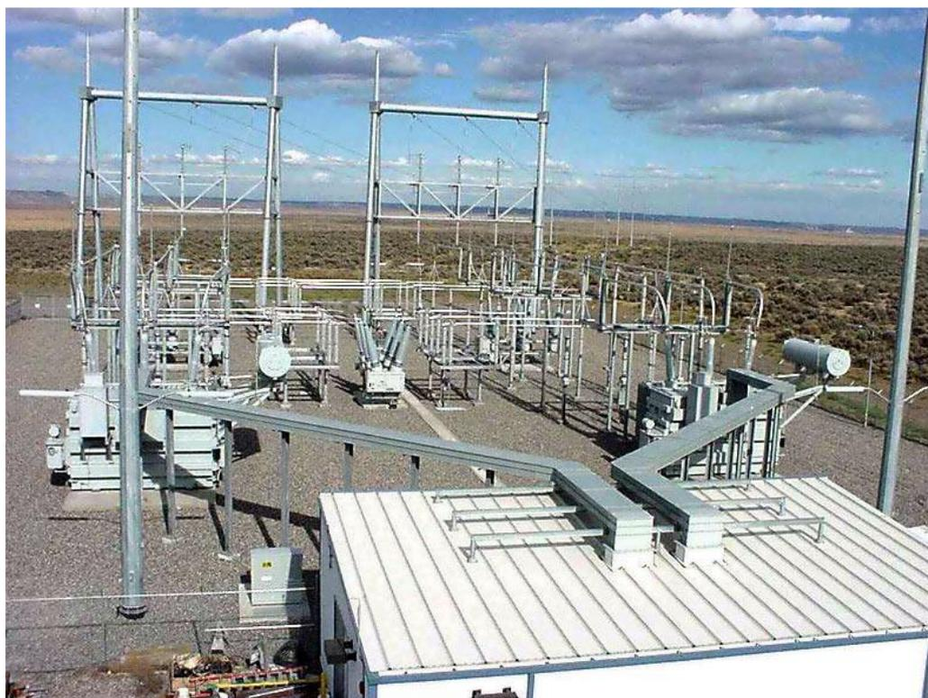
Рисунок 1 На заднем плане открытое распределительное устройство, на переднем здании закрытого распределительного устройства. Цифрами обозначены: 1 портал; 2 силовой трансформатор; токопровод для передачи электроэнергии от силового трансформатора в закрытое распределительное устройство; 4 разъединитель; 5 выключатель
