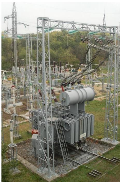
Рисунок 6 Силовой трансформатор и открытое распределительное устройство подстанции
