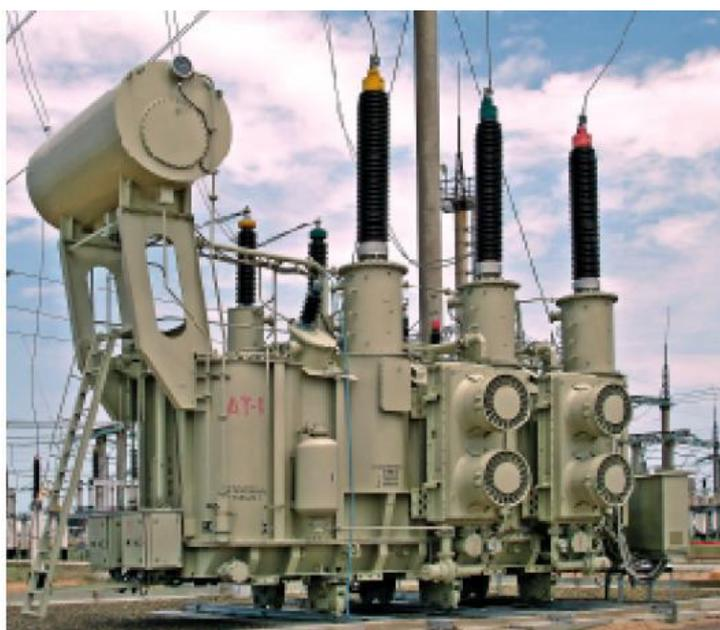
Рисунок 7 Автотрансформатор с системой охлаждения с дутьем и принудительной циркуляцией масла через воздушные охладители с вентиляторами
