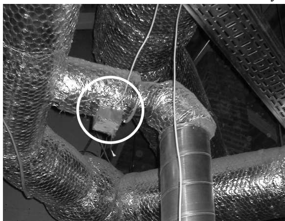
Рисунок 8 – Размещение акустического излучателя вне воздуховода
