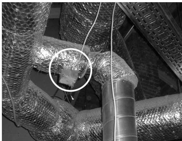
Рисунок 8 – Размещение акустического излучателя вне воздуховода
