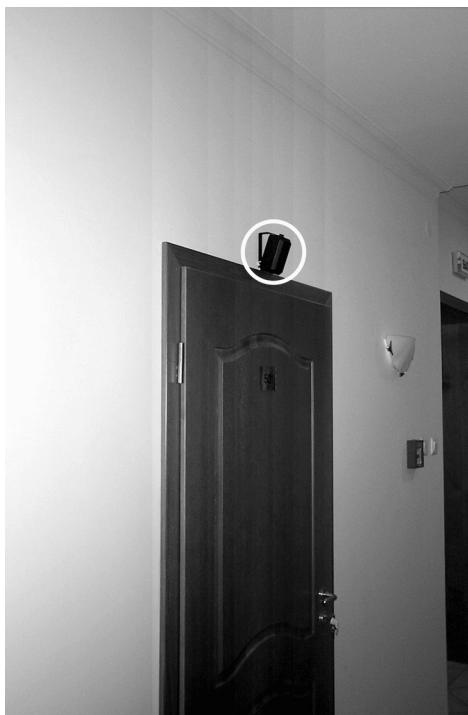
Рисунок 6 – Размещение акустического излучателя у дверного проёма с одним створом.
