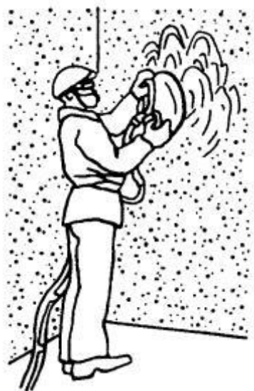
Рисунок 8 – Механизированная затирка поверхности
