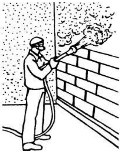
Рисунок 5 - Последовательное нанесение слоев обрызга, грунта
