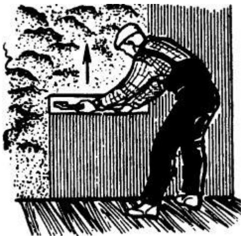
Рисунок 6 - Разравнивание раствора полутерком
