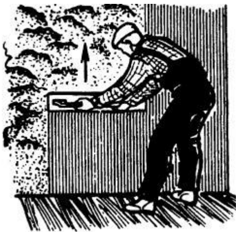
Рисунок 6 - Разравнивание раствора полутерком
