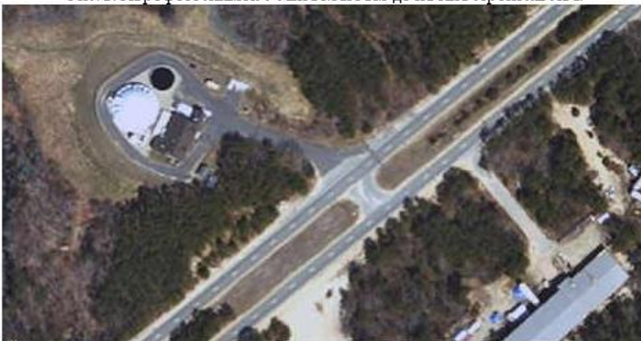
Рис. 4. Аэрофотоснимок с сайта MassGIS после завершения строительства.
