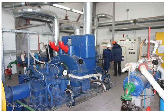
Рисунок 4.3 – Схема расположения оборудования на мини-ТЭЦ (а и б) электрической мощностью 6 МВт и вид блока мини-ТЭЦ внутри (в)
