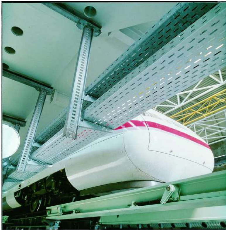
Рисунок 6.15 – Установка кабельных линий на лотках для электрифицированных железных дорог и метрополитена
