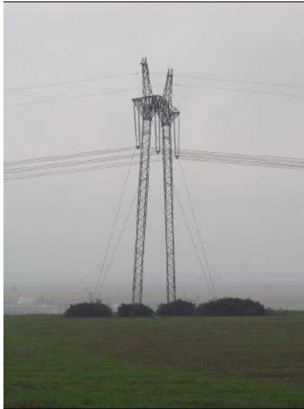
Рисунок 5.2 – Промежуточная опора ВЛЭП 750 кВ «Хмельницкая АЭС – Жешув (Польша)»
