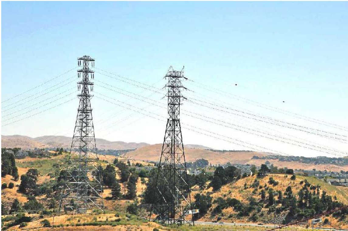
Рисунок 5.8 – Пересечение анкерных угловых опор 330 кВ и 500 кВ
