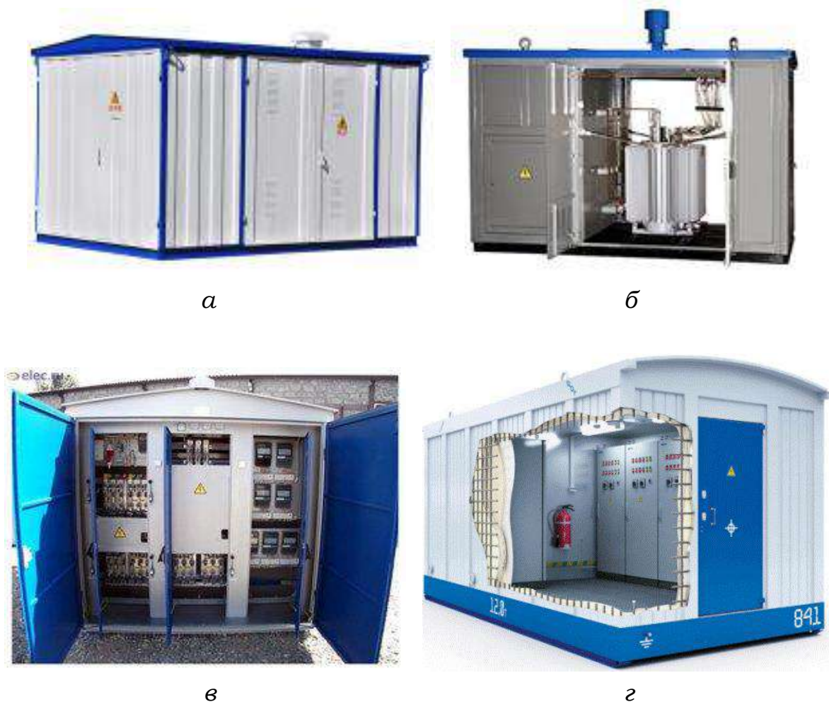
Рисунок 7.12 – Комплектные трансформаторные подстанции: а – трансформаторная подстанция КТП-2-250 кВ·А проходная; б – трансформаторная подстанция КТПГС-630 тупиковая; в – шкаф КТП (открытый); г – отдельно стоящая тупиковая КТП
