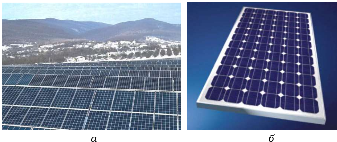
Рисунок 4.27 – Солнечная станция ( a ), использующая фотоэлектрические модули ( б )
