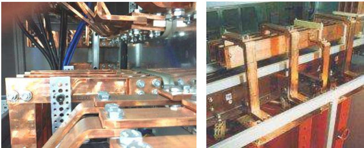
Рисунок 7.18 – Открытый шинопровод
