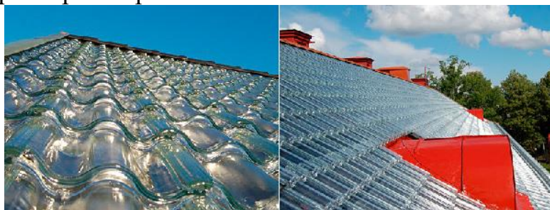
Рисунок 5. Новые технологии в строительстве - кровля из стеклянной черепицы
