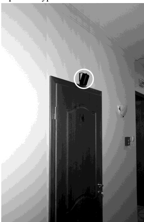
Рисунок 6 – Размещение акустического излучателя у дверного проёма с одним створом.
